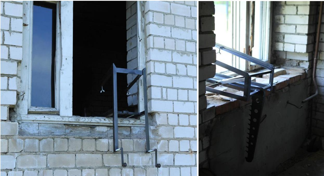
**Рис. 6.** Крепление устройства в оконном проеме наружной стены
